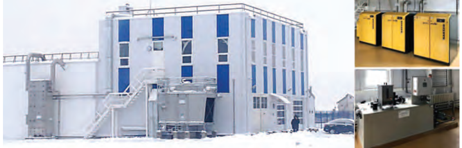
Технология ультрафильтрации на базе мембранного биореактора обеспечивает качество очистки сточных вод до показателей ПДК для сброса в естественный водоем
