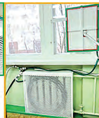
Действующая система подогрева холодной воды с использованием солнечной энергии и вторичного тепла батарей отопления в школьном кабинете физики
