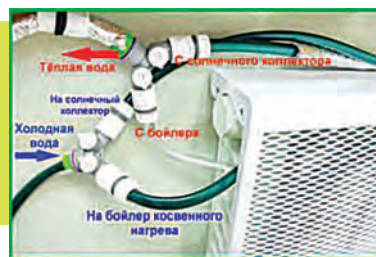
Действующая система подогрева холодной воды с использованием солнечной энергии и вторичного тепла батарей отопления в школьном кабинете физики
