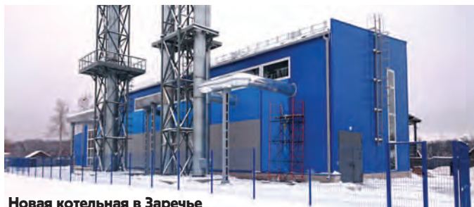
Новая котельная в Заречье
