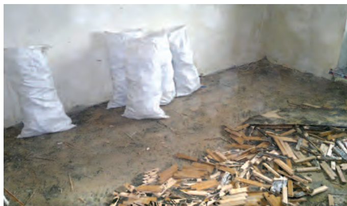
Рис. 3. Отходы после демонтажа пола
