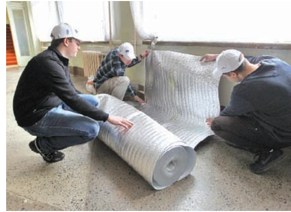
Установка теплоотражающих экранов в Витебском государственном профессионально-техническом колледже машиностроения имени М.Ф.Шмырева
