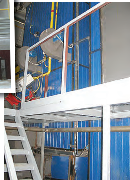
Реконструкция котельной УП «Минсккоммуналотосеть» по ул. Павловского, 66 с установкой двух котлоагрегатов на местных видах топлива суммарной мощностью 8 МВт приносит годовой экономический эффект 2599 т у.т., или 545,8 тыс. $. Срок окупаемости 5,9 лет
