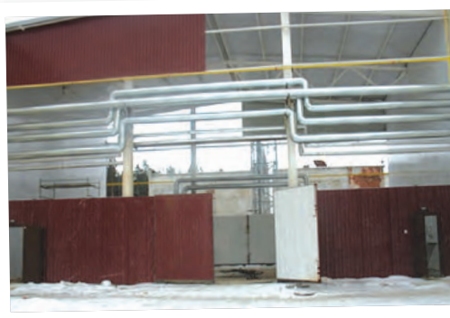
Реконструкция котельной УП «Минсккоммуналотосеть» по ул. Павловского, 66 с установкой двух котлоагрегатов на местных видах топлива суммарной мощностью 8 МВт приносит годовой экономический эффект 2599 т у.т., или 545,8 тыс. $. Срок окупаемости 5,9 лет
