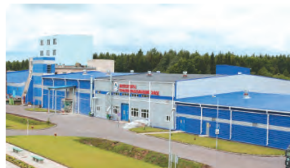
Полностью автоматизированный мощный цех УП «Витебскоблгаз» по производству торфяных питательных грунтов и кипового торфа верхового в н.п. Крулевщина Докшицкого района введен в эксплуатацию в 2008 году. Разработано около 30 составов грунтов для выращивания овощей, кустарников, других растений
