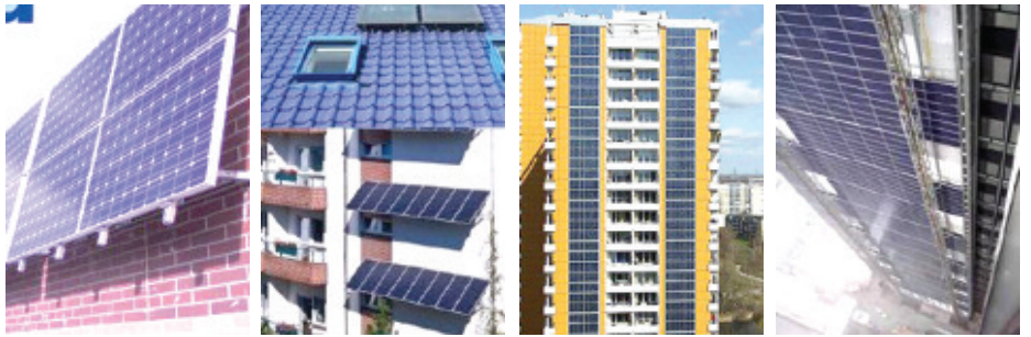
Рис. 11. Установка солнечных панелей на стенах зданий
