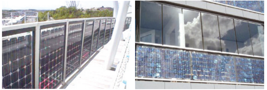
Рис. 10. Установка солнечных панелей на балконах и лоджиях
