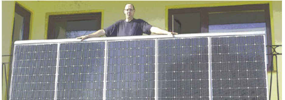
Рис. 11. Установка солнечных панелей на стенах зданий
