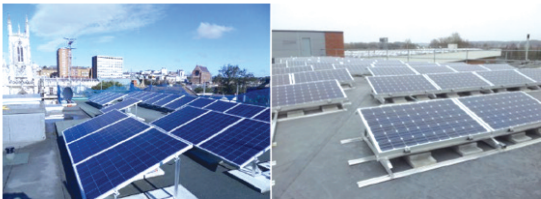
Рис. 8. Установка солнечных панелей на плоской крыше
