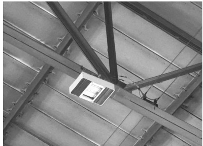
Рисунок 4 – Фотография светодиодного светильника с теплоотводом на основе тепловых труб, установленного в производственном цеху ИТМО НАН Беларуси (высота подвеса 10 м). На рисунке показана предыдущая версия светильника с теплоотводом на основе тепловых труб, запущенная в опытную эксплуатацию
