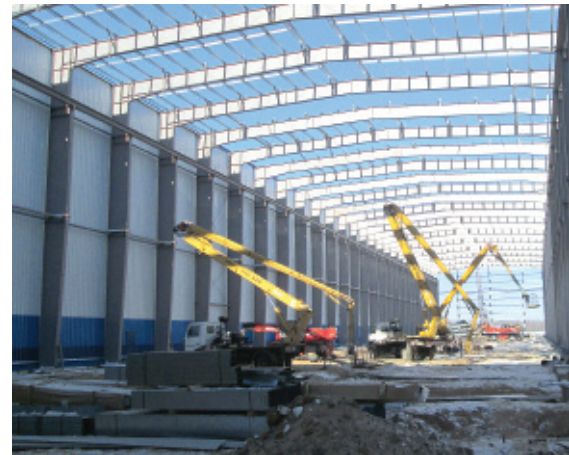
Корпуса завода ОАО «Штадлер Минск» возводятся в рекордно короткие сроки
