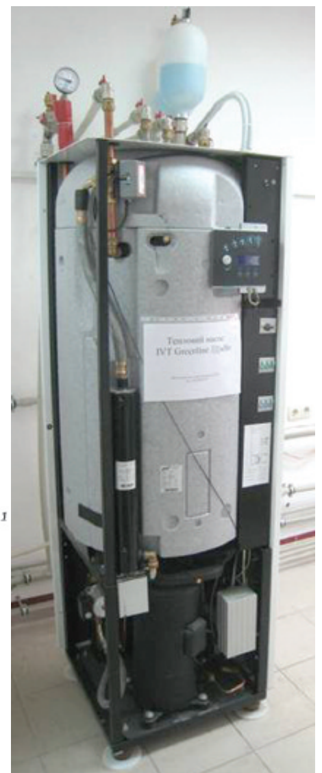
Рис. 2. ТН «грунт – жидкость»
