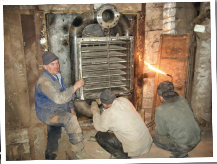
**Рис. 5.** Монтаж горелочного устройства СHT единичной мощностью 30 МВт на котле ТП-170
