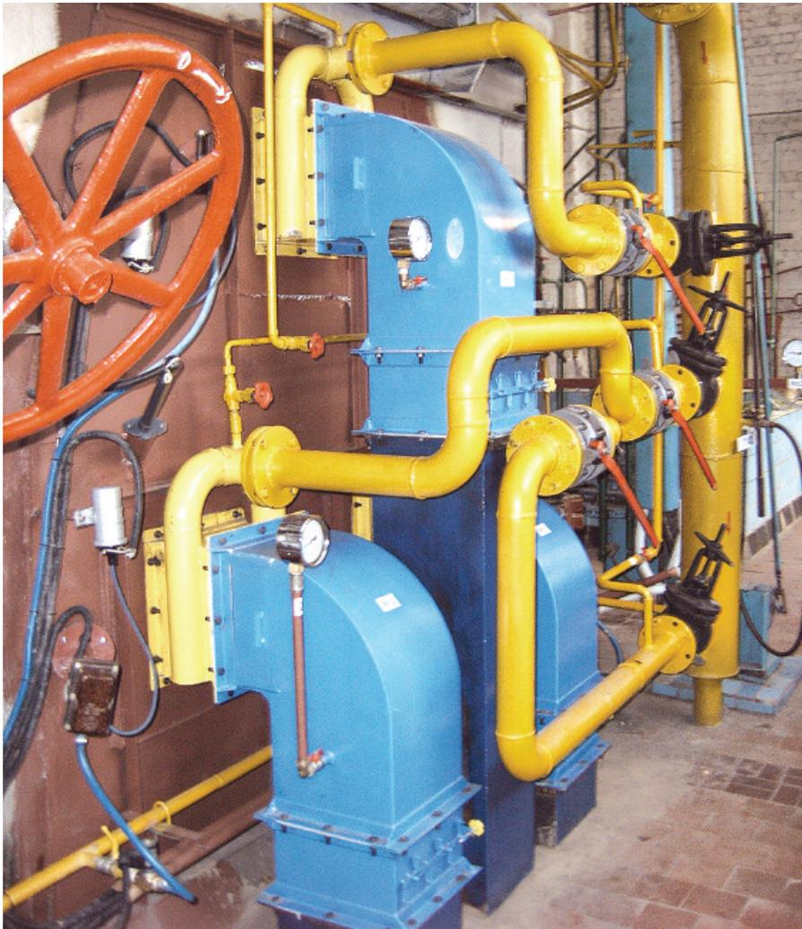
На рис. 3 показаны ГУ СНТ на котле ПТВМ-30. Горелки разжигаются при давлении 1–3 мм вод. ст. На всех 6 горелках котел работает при нагрузках от 2 до 40 Гкал/ч без отключения части ГУ. Котел может разжигаться без вентилятора и дымососа за счет самотяги трубы и при этом набирать мощность до 12–15 Гкал/ч.
