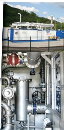
Две газопоршневые установки мощностью по 1 МВт, работающие на свалочном газе, введены в действие на полигоне ТКО «Тростенец». Их годовой экономический эффект – 2,24 тыс. т у.т., или 470,4 тыс. $; срок окупаемости проекта 4,8 года
