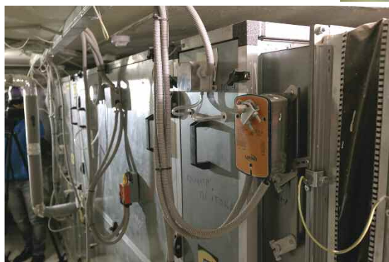
Наша экскурсия по лицу началась с подвала, где работает рекуперационная установка, теплообменники которой возвращают в здание тепло, уносимое вентиляцией
