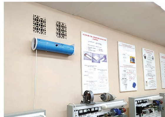
Рис. 3. Монтаж кондиционера «Белкомфорт+» на стене учебной лаборатории колледжа
