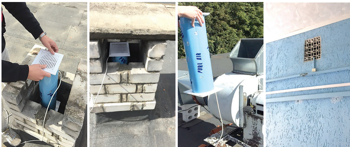
Рис. 2. Монтаж кондиционера «Белкомфорт+» в вентиляционной шахте на крыше мастерских колледжа
