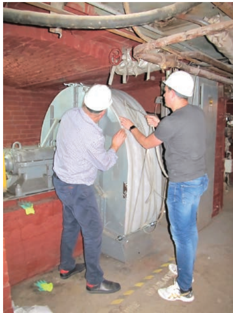
◆ Рис. 1. Монтаж пластин на внешнюю сторону улитки тягодутьевого вентилятора ВД-10 котла ДКВР-10/13 ст. № 3
