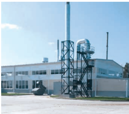
◆ Котельная в г. Славгороде по ул. Калинина
