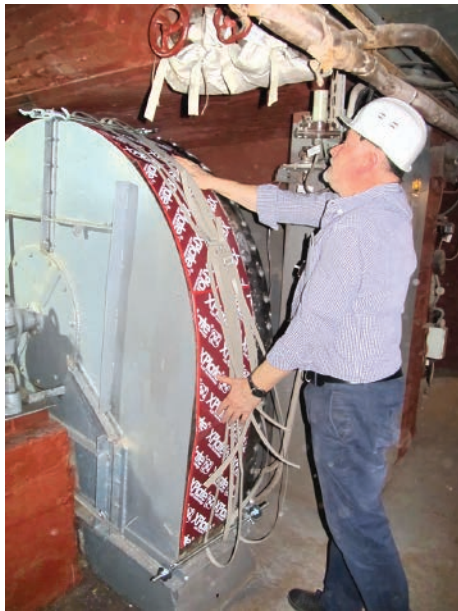
◆ Рис. 1. Монтаж пластин на внешнюю сторону улитки тягодутьевого вентилятора ВД-10 котла ДКВР-10/13 ст. № 3
