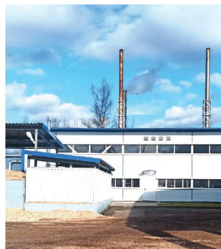
◆ Котельная на МТЭР в г. Каменец мощностью 4 МВт
