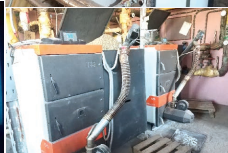
◆ Комбинированный энергоисточник ГУО «Ясли-сад №9 г.Орши» (гелиоколлекторная установка и пеллетные котлоагрегаты, работающие в автоматизированном режиме загрузки топлива)
