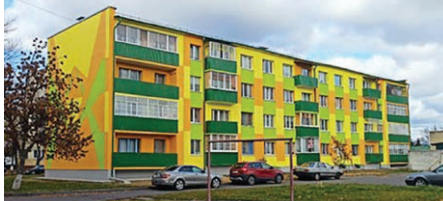
◆ Лунинец, ул. Лисовича, 1 – жилой дом до и после проведения энергосберегающих мероприятий
