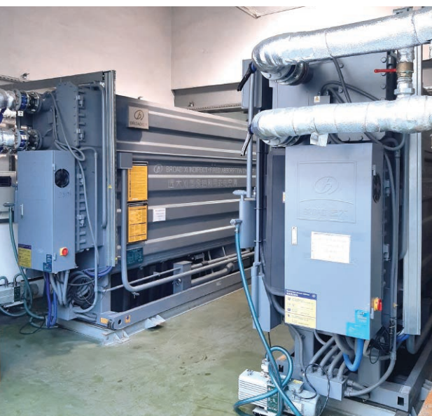
◆ Рис. 2. Абсорбционные холодильные установки BROAD BDH75
