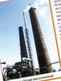
Рис. 1. Общий вид котельной
