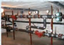
Для регулирования отопления на уровне дома в зависимости от погодных условий: установка/модернизация автоматизированного индивидуального теплового пункта
