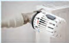
Для достижения предпочитаемого теплового режима в своей квартире: установка на радиаторы термостатических регуляторов (слева)
