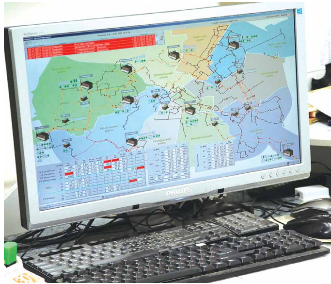
Рис. 1. Кадр панели операторской станции автоматизированной системы управления теплоснабжением Минских тепловых сетей
