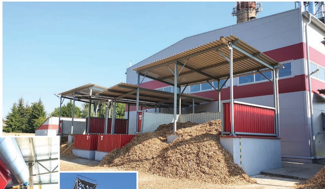
◆ Склад топлива котельной №50
