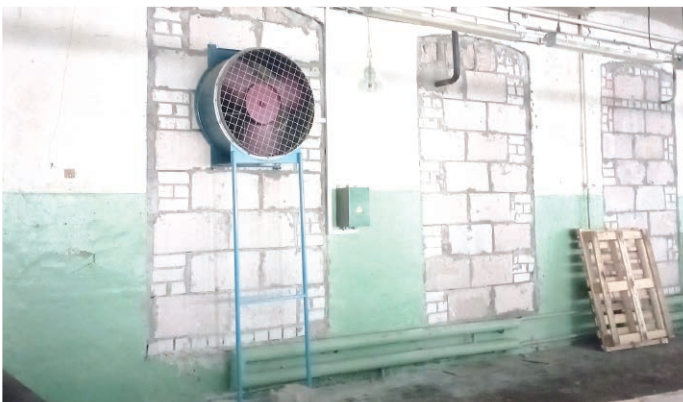
◆ Устройство утилизации тепла выбросов компрессоров для нужд отопления
