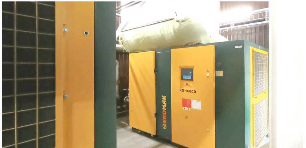
◆ Устройство утилизации тепла выбросов компрессоров для нужд отопления
