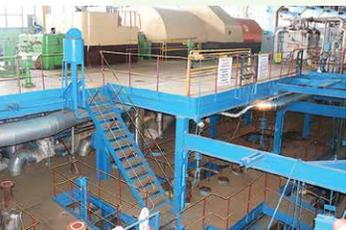
Паровая турбина эксплуатировалась с 1971 года и за это время исчерпала свой ресурс. Новая турбина будет установлена на частично реконструированном фундаменте прежнего агрегата с заменой вспомогательного оборудования и трубопроводов.
