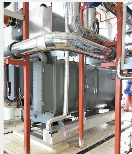
АБХМ специального низкотемпературного исполнения в проекте тригенерации для ОАО «Савушкин продукт» в Пинске
