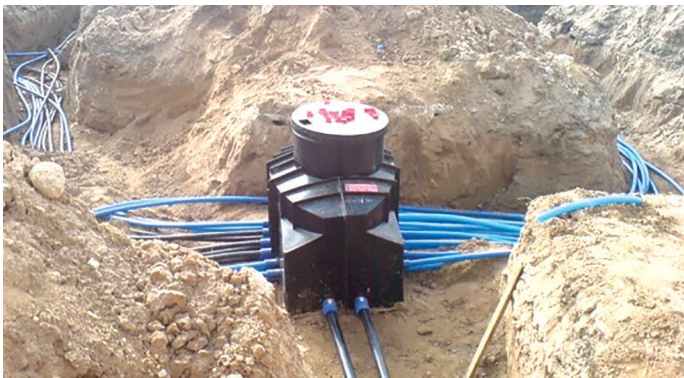
Рис.4. Вид на грунтовый теплообменник в ходе выполнения строительно-монтажных работ
