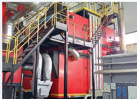
*Установленная тепловая мощность котельной: 12 МВт. Здесь установлены три котла, работающие на древесной биомассе (щепе), отечественного производства единичной мощностью 4 МВт. Создано 6 рабочих мест. Простой срок окупаемости: 4,3 года.*
