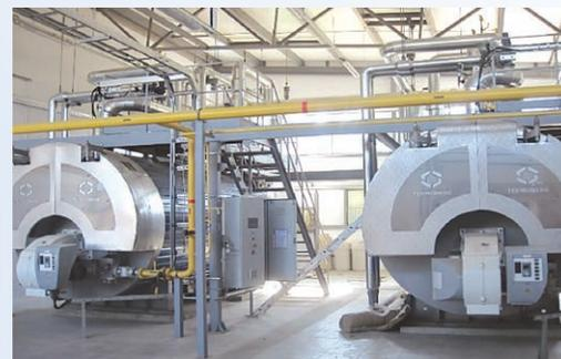
*Установленная тепловая мощность котельной: 18,0 МВт. Здесь установлены котлы, работающие на древесной биомассе (щепе), единичной мощностью 5,0 МВт (2 шт.); 2,0 МВт (1 шт.) и котлы, работающие на природном газе, единичной мощностью 3,0 МВт (2 шт.). Создано 15 рабочих мест. Простой срок окупаемости: 4,7 года.*
