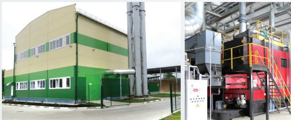
*Установленная тепловая мощность котельной: 7,5 МВт. Здесь установлены котлы, работающие на древесной биомассе (щепе), отечественного производства единичной мощностью 3,5 МВт, 3 МВт и 1 МВт со вспомогательным оборудованием. Создано 6 рабочих мест. Простой срок окупаемости: 5,2 года.*
