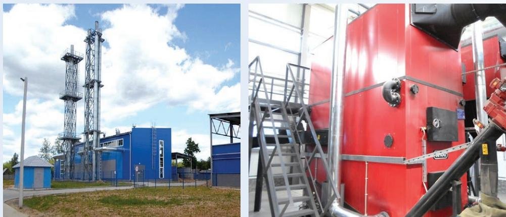
*Установленная тепловая мощность котельной: 10,8 МВт. Здесь установлены три котла, работающие на древесной биомассе (щепе), единичной мощностью 2,1 МВт, а также газовый котел мощностью 4,5 МВт отечественного производства. Создано 4 рабочих места. Простой срок окупаемости 4,5 года.*
