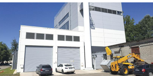
Рис. 4. Твердотопливная водогрейная котельная в центре Риги
