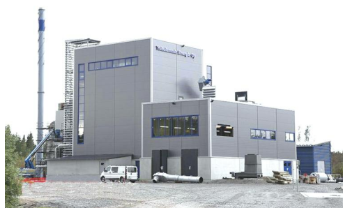
Рис. 3. Мини-ТЭЦ на базе твердотопливной паровой котельной и ORC-технологии
