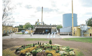
Рис. 6. Станция на биомассе в городе Саласпилс
