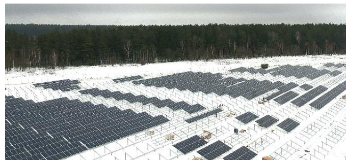
Проведение строительно-монтажных работ по установке солнечно-модульной станции мощностью 109 МВт в Чериковском районе
