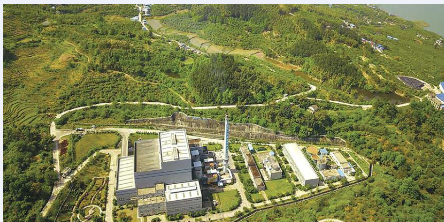
Мусоросжигательная электростанция (МСЭС) города Чунцин
