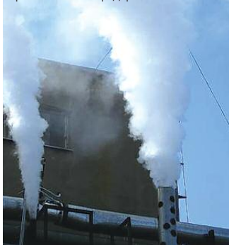
Рис. 6. Выпар из конденсатного бака на промышленном предприятии
