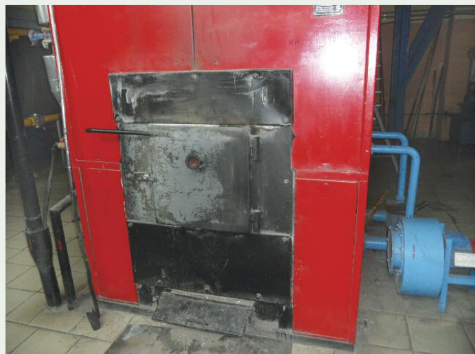
Котельная в г. Климовичи по ул. Кирова: котел на МВТ до и после реконструкции
