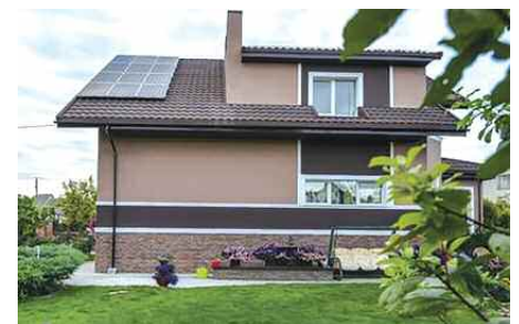
Пример установленной системы аккумуляирования энергии в г. Минск Частный дом (г. Минск): среднее суточное потребление – 25 кВт·ч; мощность солнечной станции – 5 кВт; емкость LFP аккумуляторов – 16 кВт·ч.
