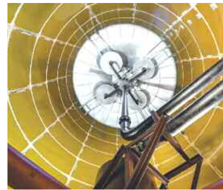
Рис. 4. Антикоррозийная защита и компоновка внутренних элементов бака
